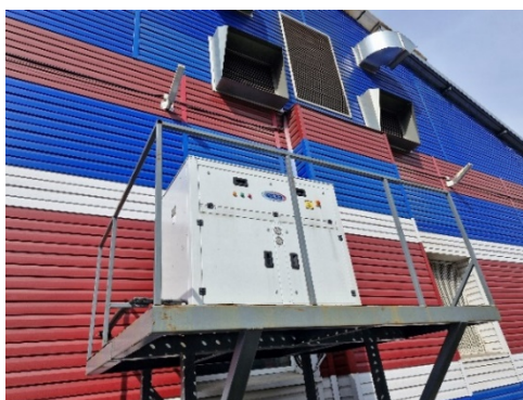
Рис. 4. Компрессорно-конденсаторный блок МАКК-Т
