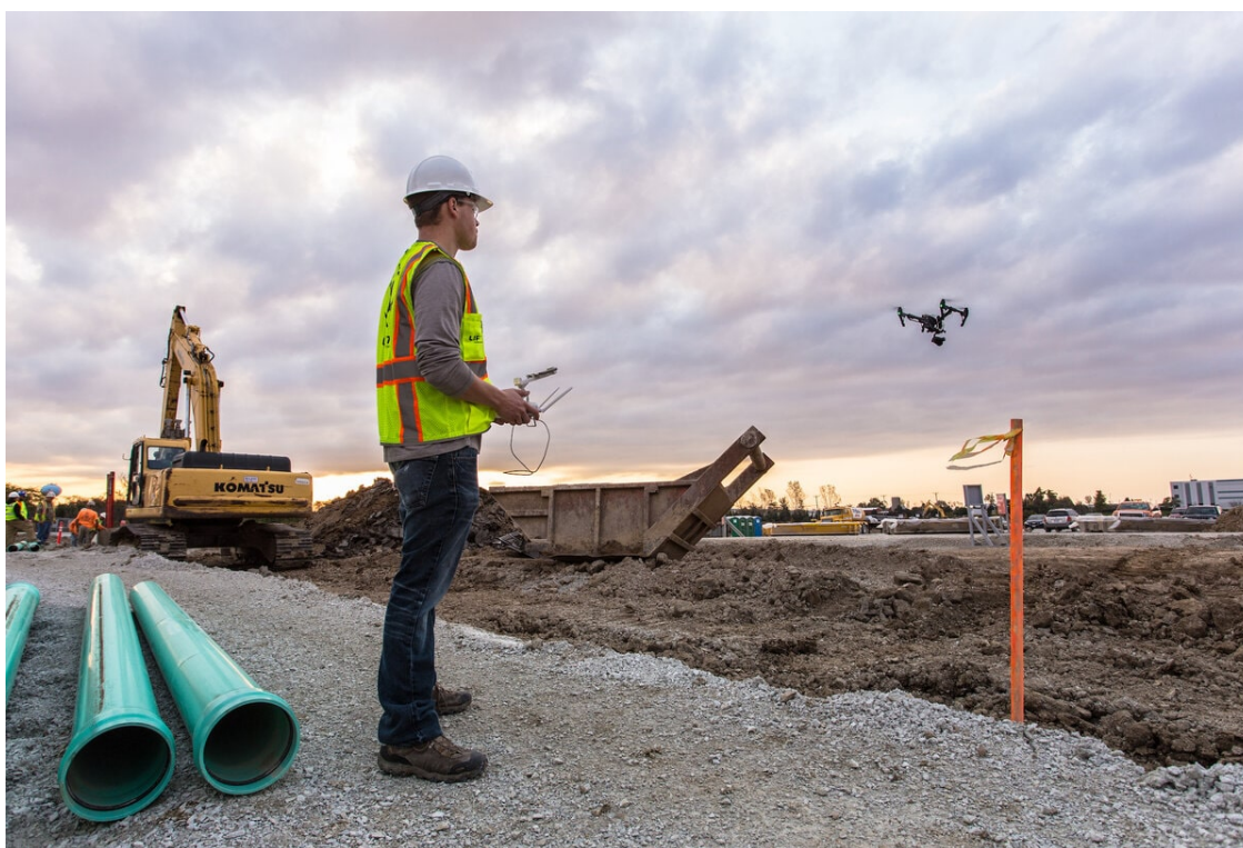
Рис. 3. Сканирование строительной площадки
