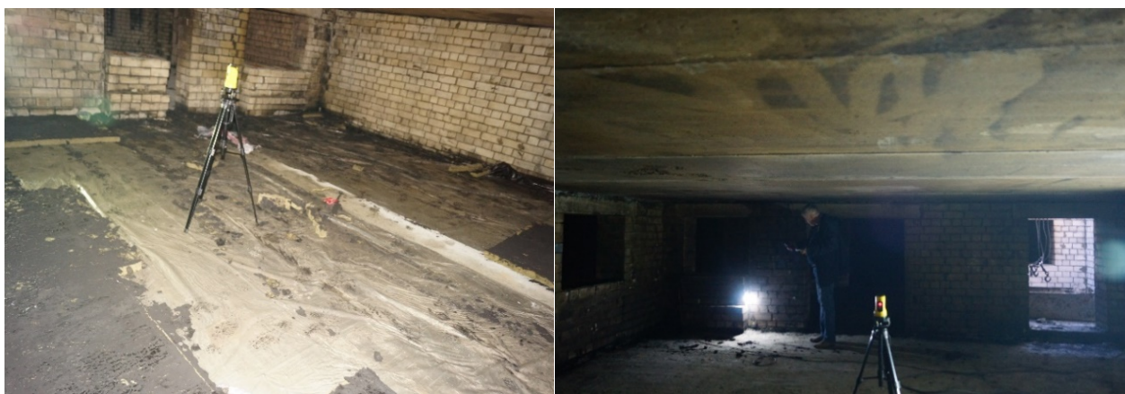
Рис. 2. Определение прогибов плит
