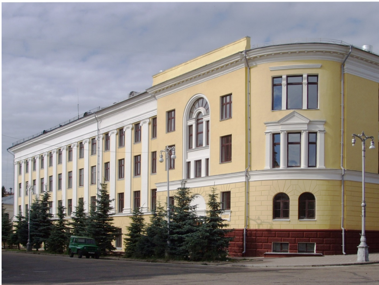
Рис. 7. Застройка ул. К. Маркса, арх. В.Н. Городков, А.Э. Фридман
