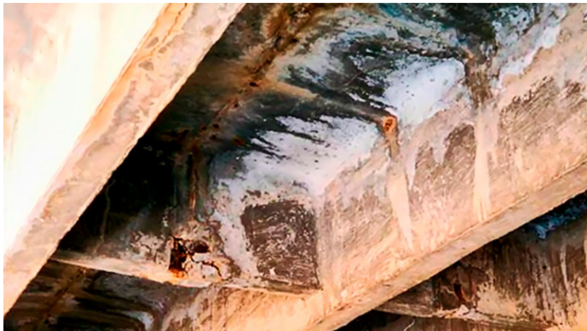
Рис. 1. Хлоридная коррозия
