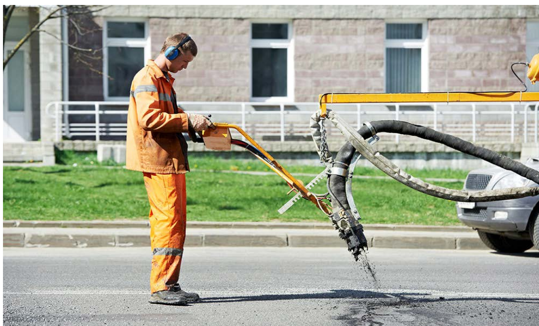
Рис. 1. Струйно-инъекционный метод восстановления поверхности дорожных покрытий
