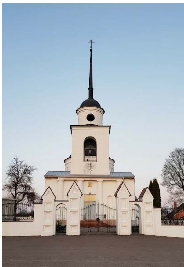
Рис. 5. Церковь Спаса Нерукотворного Образа. Дефекты звонницы отсутствуют
