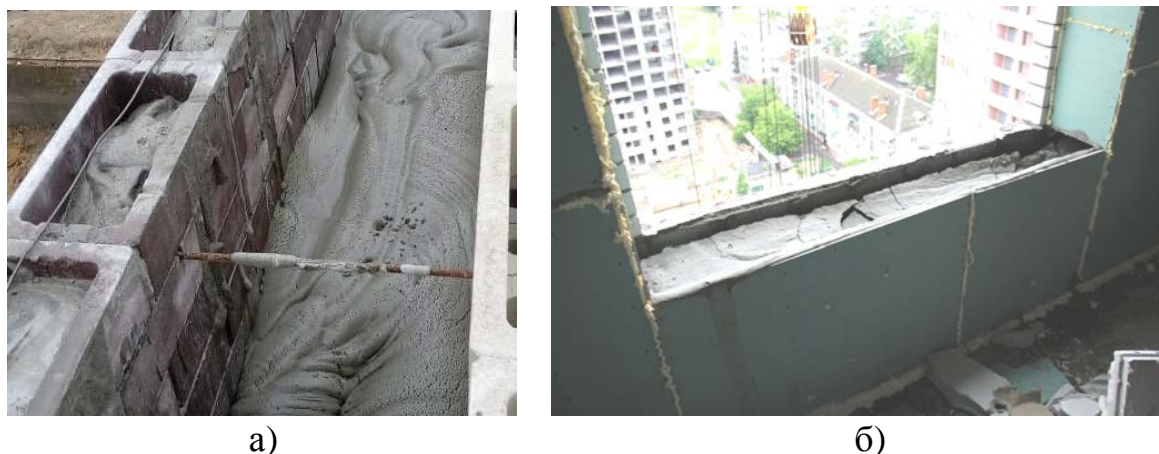
Рис. 2. Общий вид наружных стен с использованием монолитного пенобетона
