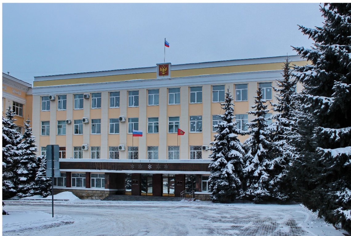
Рис. 3. Пристройка к зданию Брянского облисполкома (1975)
