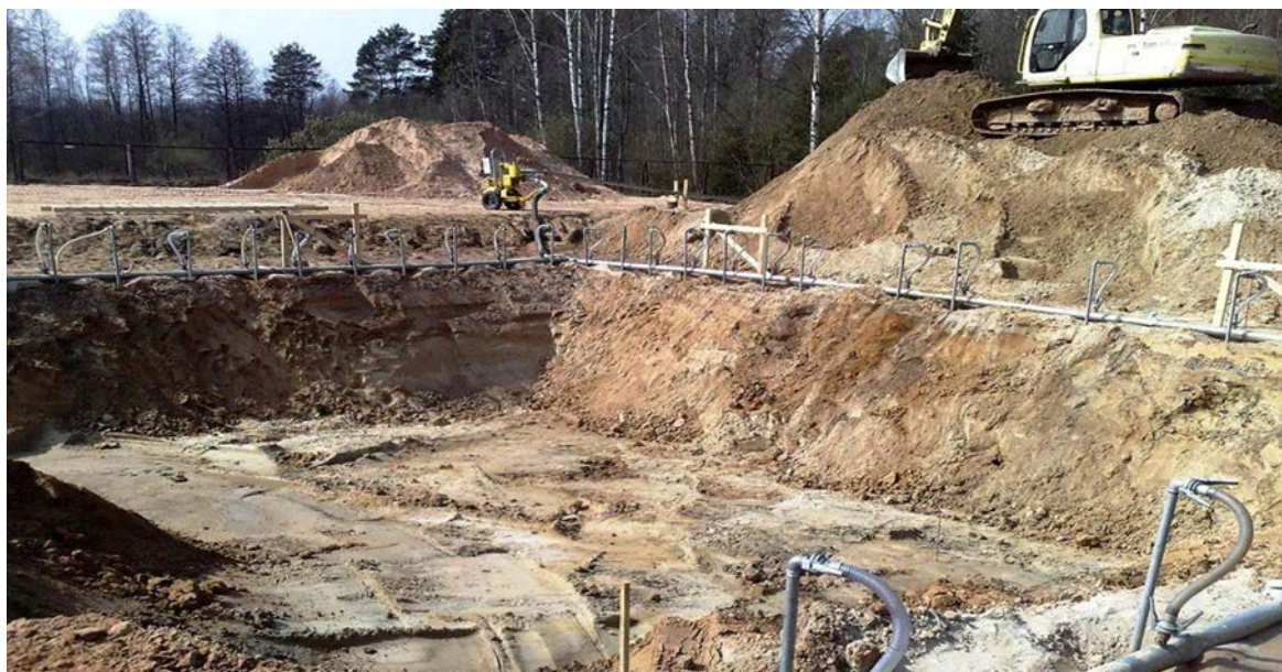
Рис.1. Работы по устройству фундамента с работами по водопонижению
